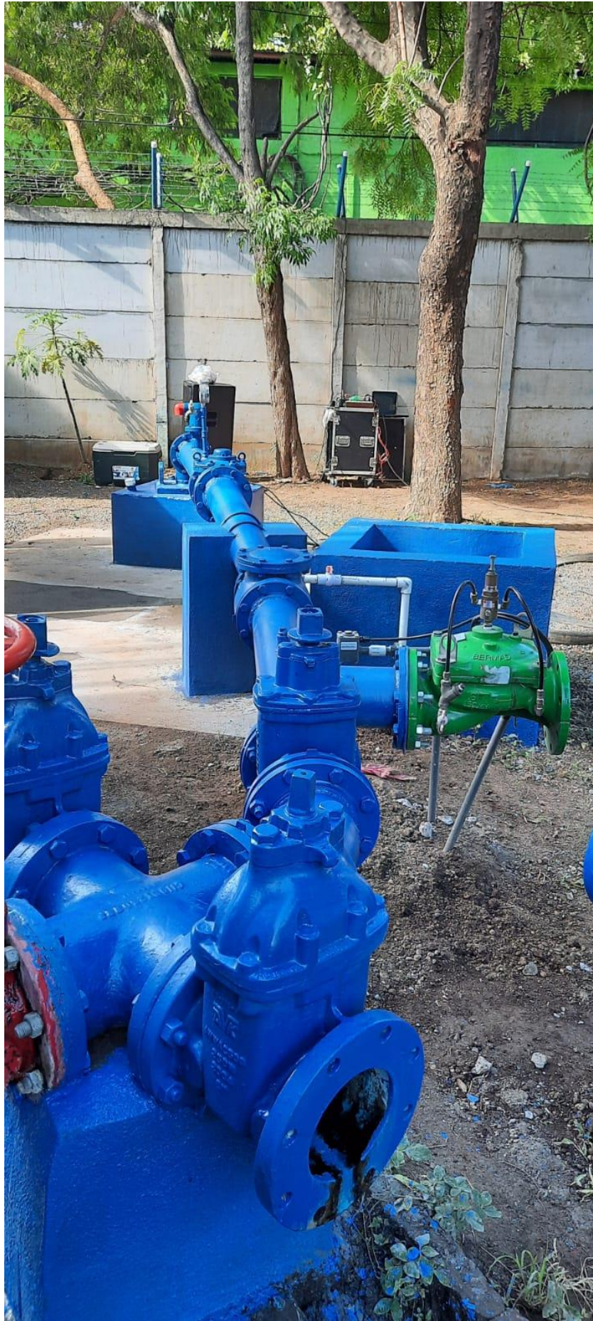
Nuevo pozo concluido y en operación.
