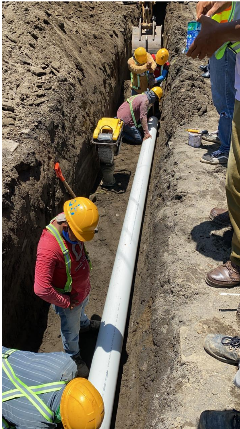
AVANCES EN INSTALACIÓN DE TUBERÍAS
