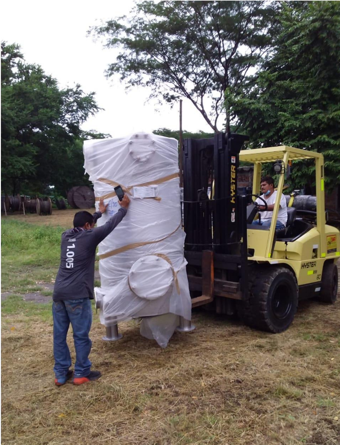
Parte del Equipamiento a instalar.
