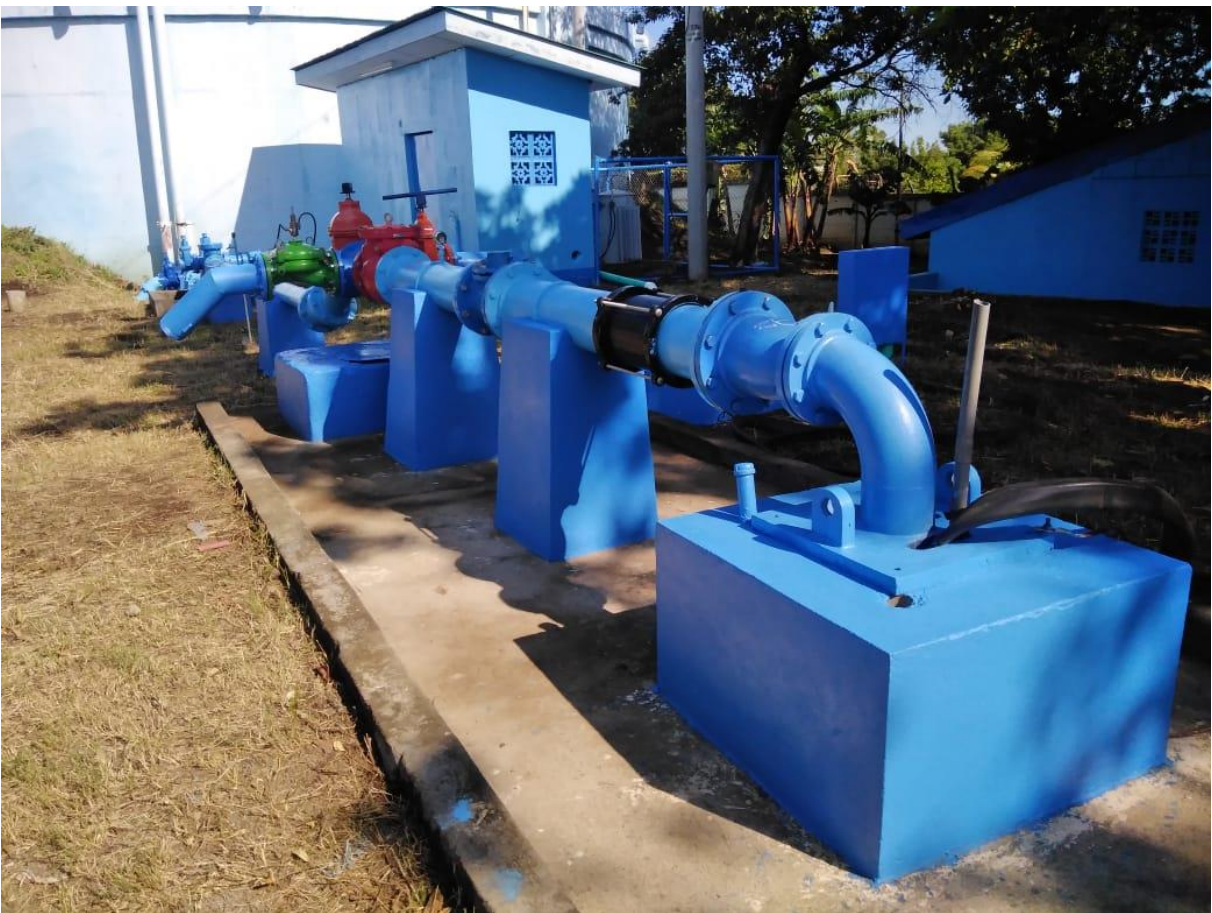
Nuevo pozo concluido y en operación.
