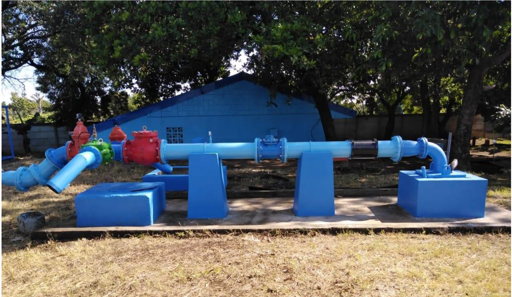
Nuevo pozo concluido y en operación
