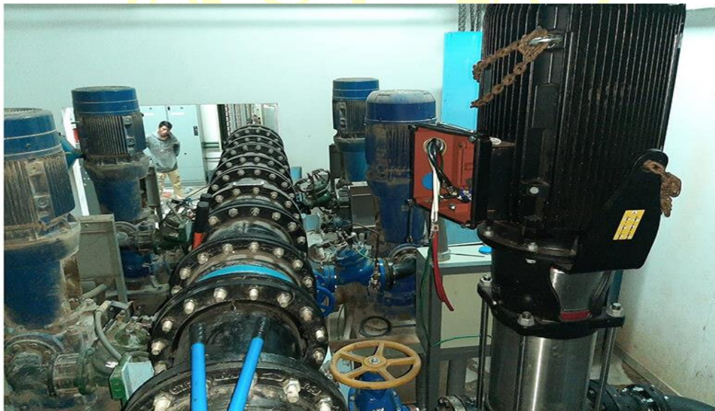
REFORZAMIENTO CON NUEVOS EQUIPOS DE BOMBEO.
