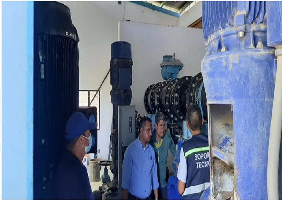
REFORZAMIENTO CON NUEVOS EQUIPOS DE BOMBEO
