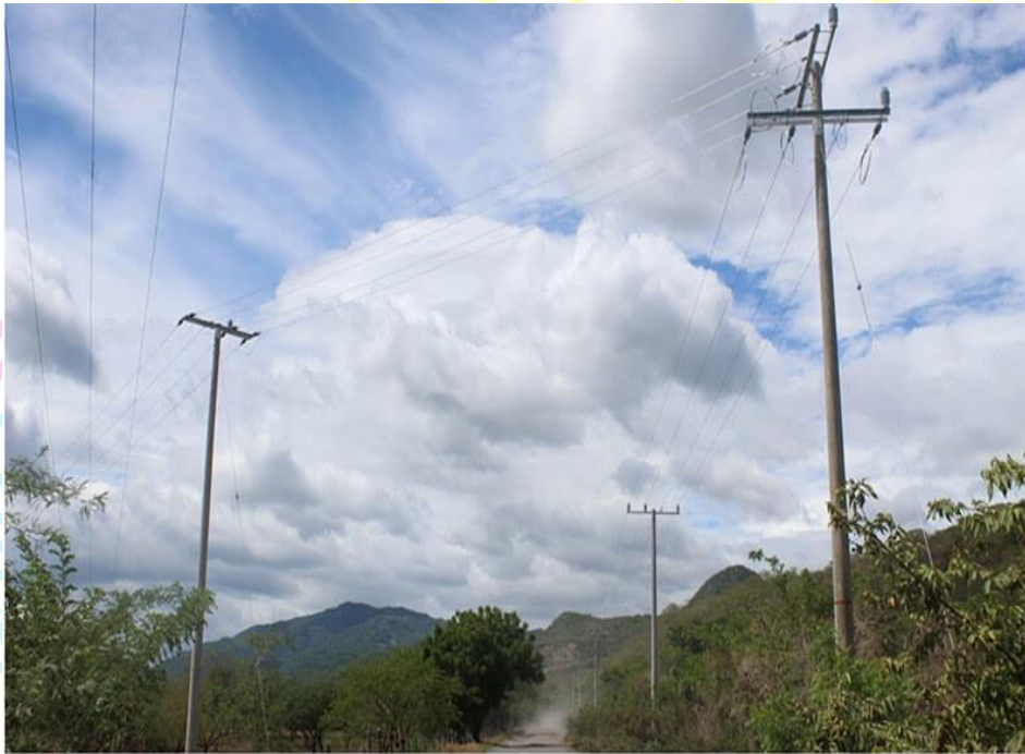
INSTALACIÓN DE 15 KILÓMETROS DE REDES ELÉTRICAS
