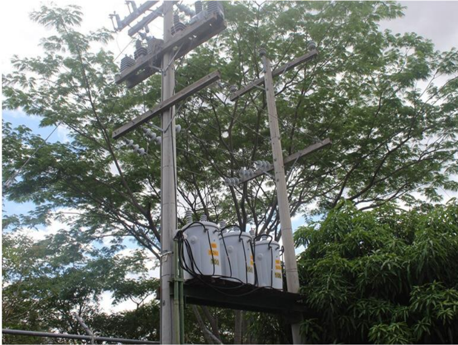
REPOTENCIACIÓN BANCOS DE TRANSFORMADORES.
