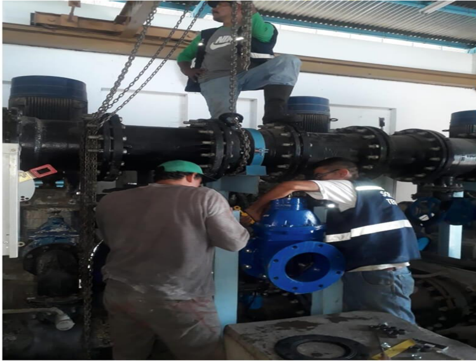
REFORZAMIENTO CON NUEVOS EQUIPOS DE BOMBEO
