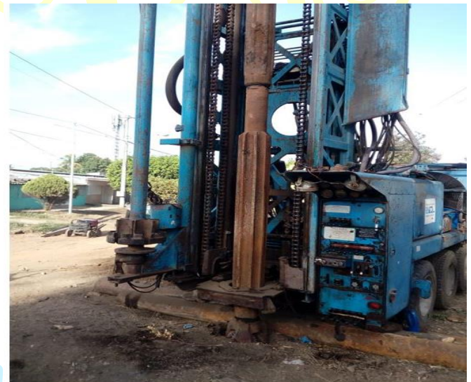
Proceso de perforación.
