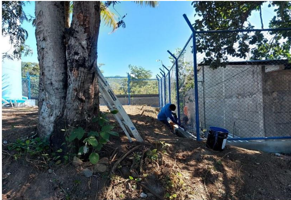
REHABILITACIÓN DE CERCA EN PREDIO DE TANQUES Y POZO
