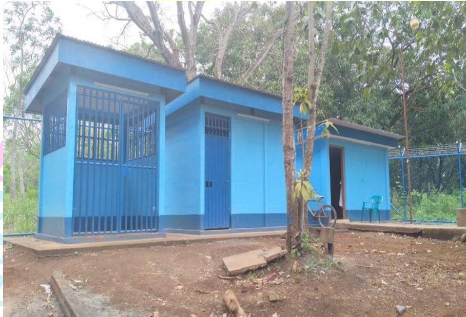
CONSTRUCCIÓN DE CASETA PARA EQUIPOS ELÉCTRICOS.
