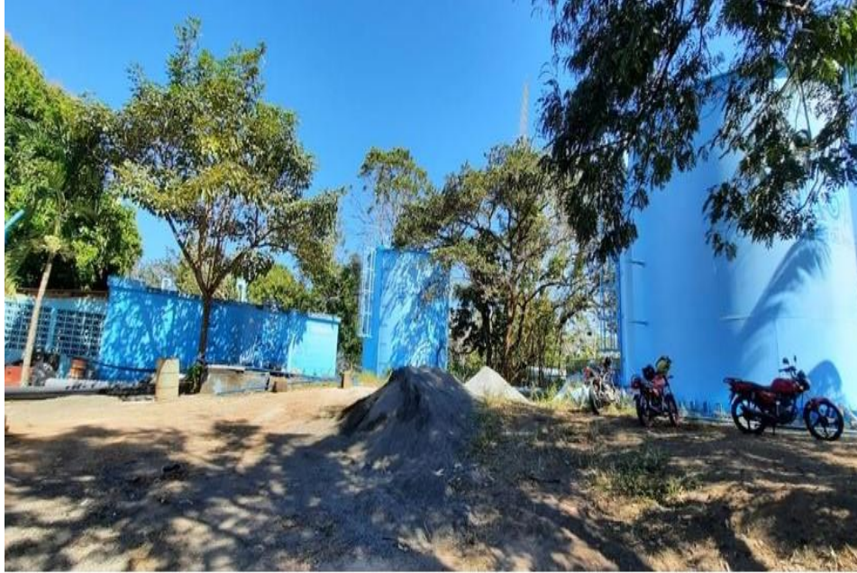
PREDIO DE TANQUES Y REBOMBEO.
