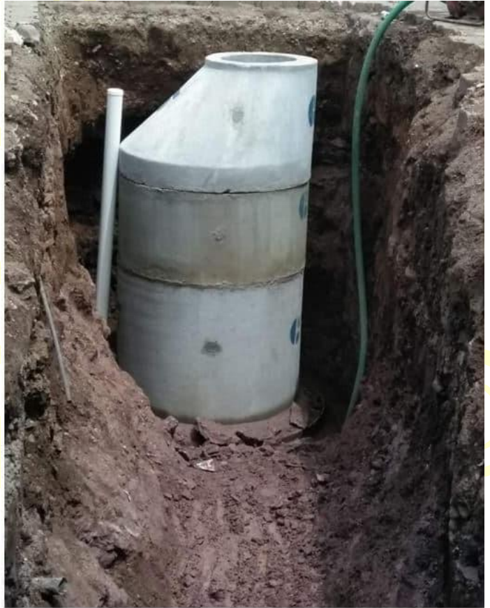
Instalación de 108 Manjoles.
