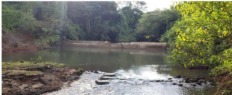
Obra de captación río La Sardina.
