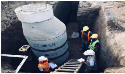
Construcción de 506 manjoles.
