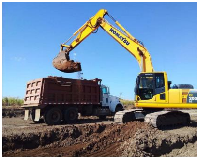
Movimiento de tierra en planta de Tratamiento de Aguas Residuales.
