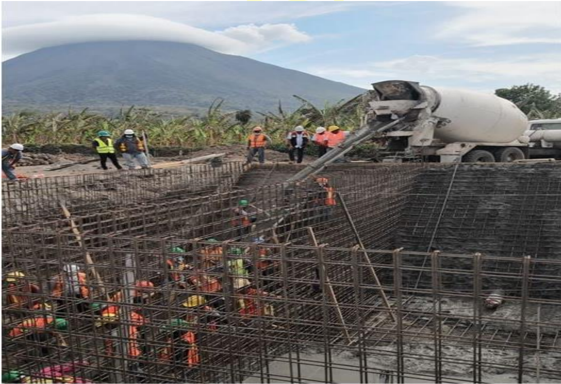
Lechos de secados en planta de tratamiento.
