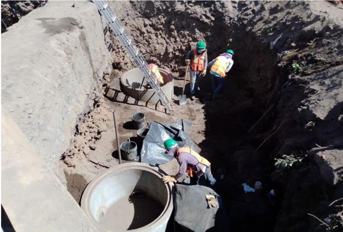
Construcción de 221 manjoles.
