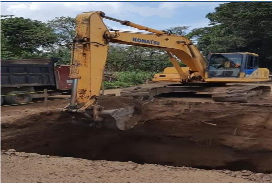
Excavación para estación de bombeo.
