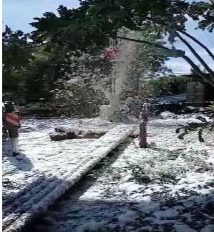
Rehabilitación de pozo en Los Urroces, León.
