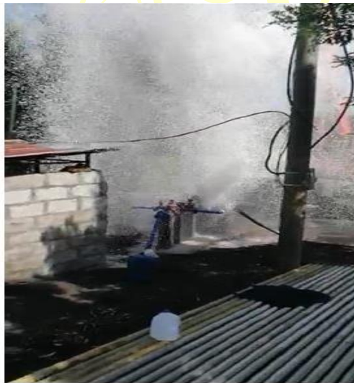
Rehabilitación de pozo en Los Urroces, León.
