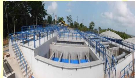
Las obras consisten en la construcción de: un dique-toma en el río Kukra y en el caño Silva; planta de tratamiento de agua potable y 2 estaciones de bombeo; cuatro tanques de almacenamiento de acero vitrificado con una capacidad conjunta de 6,427 metros cúbicos; instalación de 127 kilómetros de tuberías de redes de distribución y conducción, colocación de 10 mil conexiones domiciliarias; la instalación de 40.4 kilómetros de la líneas eléctricas de media tensión.
