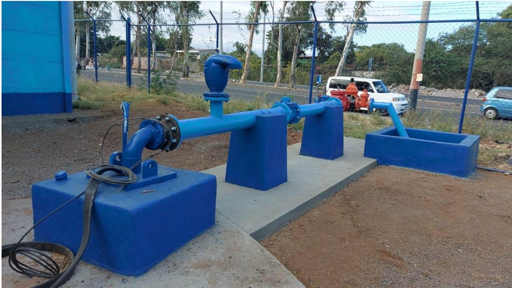
NUEVO POZO CONCLUIDO.
