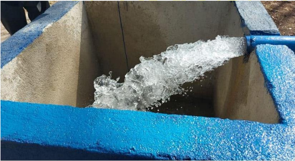
Obras en el Nuevo Pozo.
