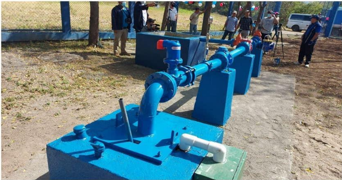
Obras en el Nuevo Pozo.
