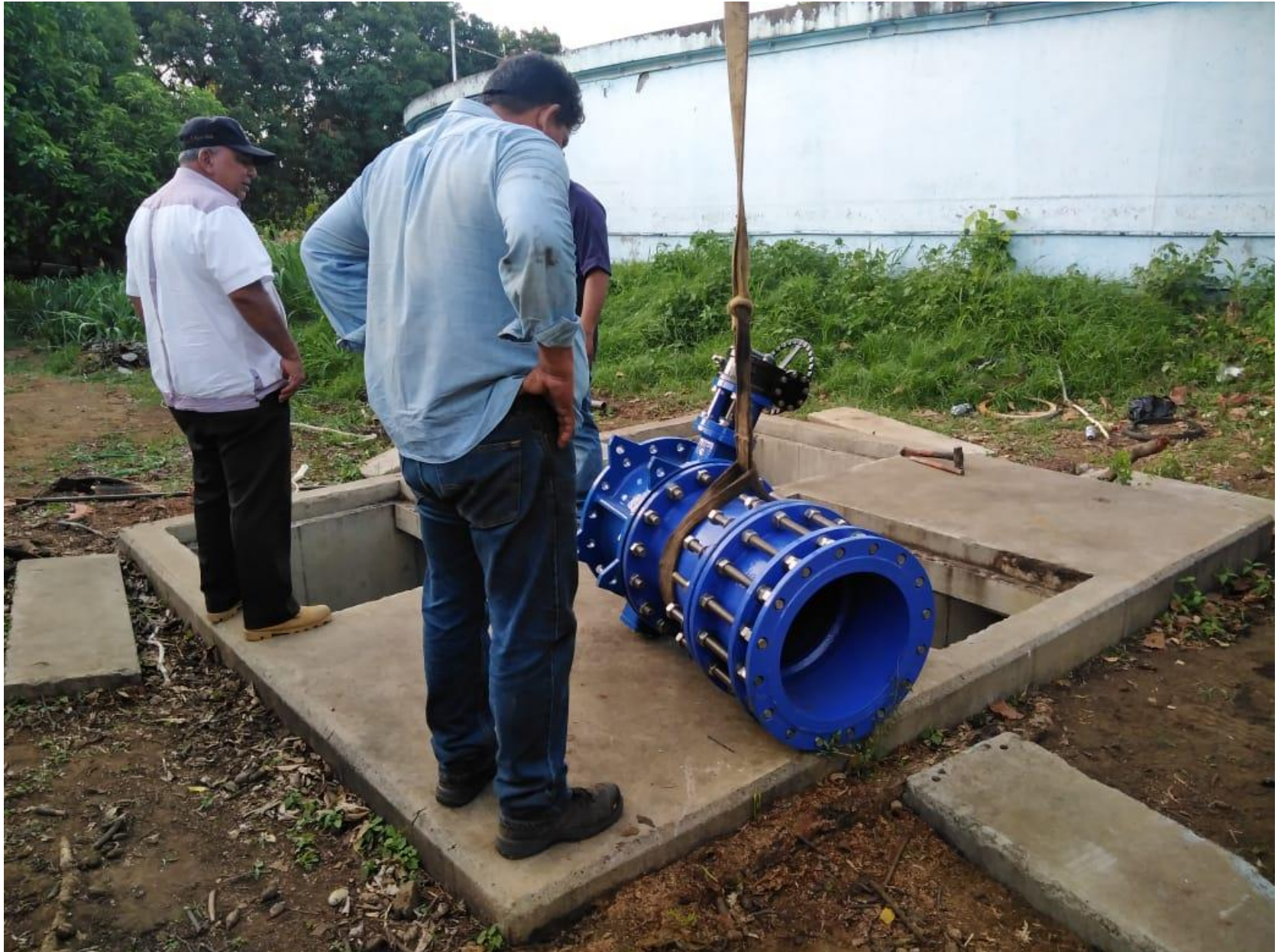
Mejoras en rebombeo altamira y Km 8 Carretera Masaya.
