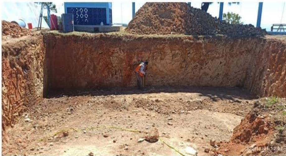
Construcción de nuevo tanque.
