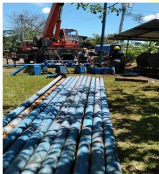
Rehabilitación de Motor y Bomba.
