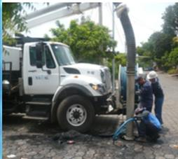
Los trabajadores de las cuadrillas hacen uso de diversas herramientas manuales como sondas, llaves de sondas, piochas, picos, barras, desarenadores, rescata-dores, colochos, almejas, puntas de arpón, y corta-raíces. Además, utilizan equipos mecánicos especiales de presión y succión de agua para resolver grandes problemas de obstrucción, entre ellos hidrojets y camiones VACTOR, AQUATECH e IVECO.
