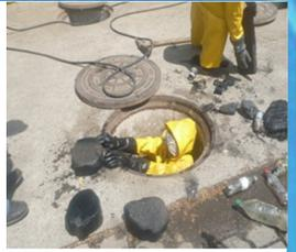
A veces se presentan casos de obstrucciones muy complejas en las redes, que implican mucho tiempo y esfuerzo, empleo de diversas técnicas de desobstrucción, hasta rotura de tramos de redes y sustitución de tuberías. También debido al crecimiento desordenado de la ciudad, en muchos casos las tuberías y manjoles han quedado a lo interno de viviendas y propiedades privadas, lo complica la atención a algunas ocurrencias presentadas.
