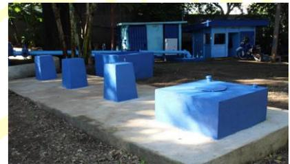
Los trabajos incluyen: Obras civiles, perforación, equipamiento y energización del nuevo pozo, con una producción estimada de 650 galones por minuto, a una profundidad de 1,100 pies.
