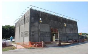
Edificio de tamizado de lodos primarios.
