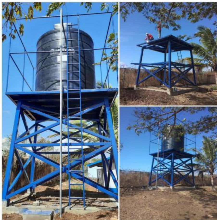
ADQUISICIÓN E INSTALACIÓN DE TANQUE DE ALMACENAMIENTO.
