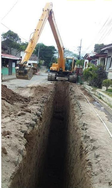
Excavación para instalación DE 13.2 kilómetros de tuberías.
