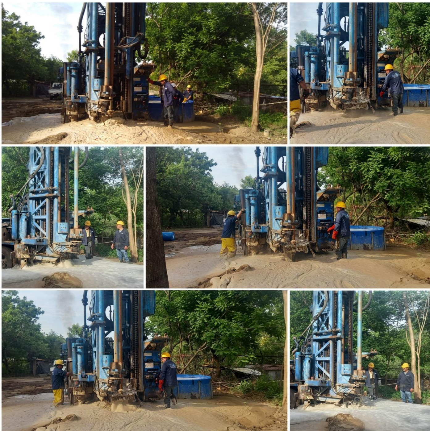
INICIO Y AVANCES EN PERFORACIÓN DE NUEVO POZO EN SECTOR DE CUAJACHILLO, CIUDAD SANDINO, MANAGUA.
