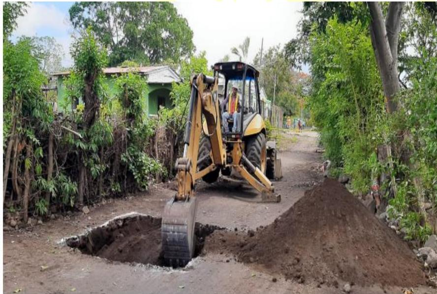
**Excavación para construcción de Manjoles.**
