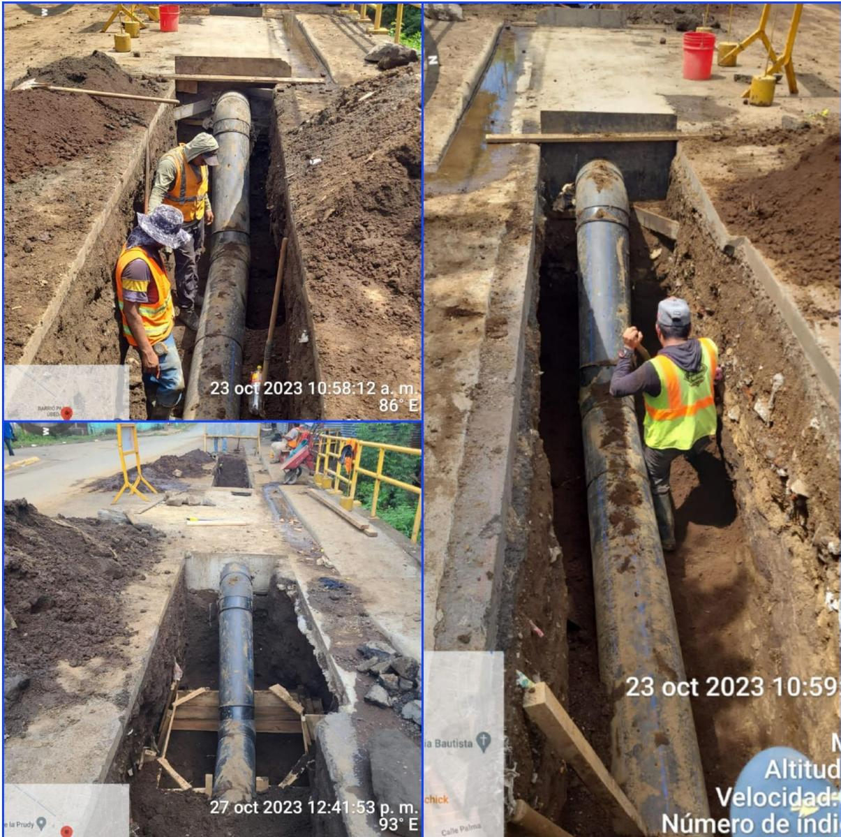
**AVANCES DE PROYECTO DE AGUA EN MANAGUA. SUSTITUCIÓN DE TUBERÍAS EN TRAMOS PRIOROTARIOS.**
