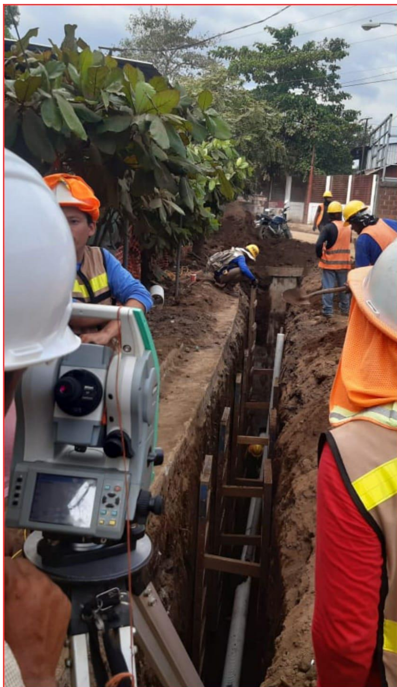
BARRIO EL PUEBLITO REALIZANDO EXCAVACION PARA PROCEDER CON INSTALACION DE TUBERIA. PROYECTO: "MEJORAMIENTO Y AMPLIACIÓN DEL SISTEMA DE ALCANTARILLADO SANITARIO Y DE TRATAMIENTO DE AGUAS RESIDUALES DE LA CIUDAD DE CHICHIGALPA"
