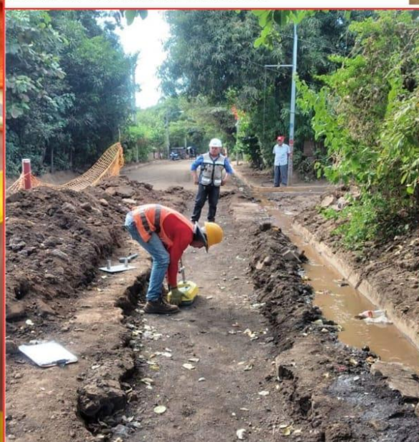
BARRIO MARVIN SALAZAR ESTE, PRUEBAS DE COMPACTACION PARA PROCEDER A INSTALAR CARPETA DE ADOQUINES. PROYECTO: "MEJORAMIENTO Y AMPLIACIÓN DEL
