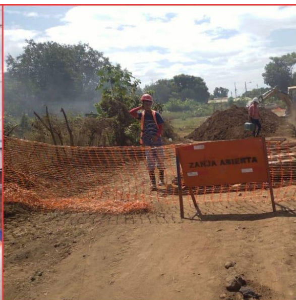
BARRIO EL PUEBLITO REALIZANDO EXCAVACION PARA PROCEDER CON INSTALACION DE TUBERIA. PROYECTO: "MEJORAMIENTO Y AMPLIACIÓN DEL SISTEMA DE ALCANTARILLADO SANITARIO Y DE TRATAMIENTO DE AGUAS RESIDUALES DE LA CIUDAD DE CHICHIGALPA"
