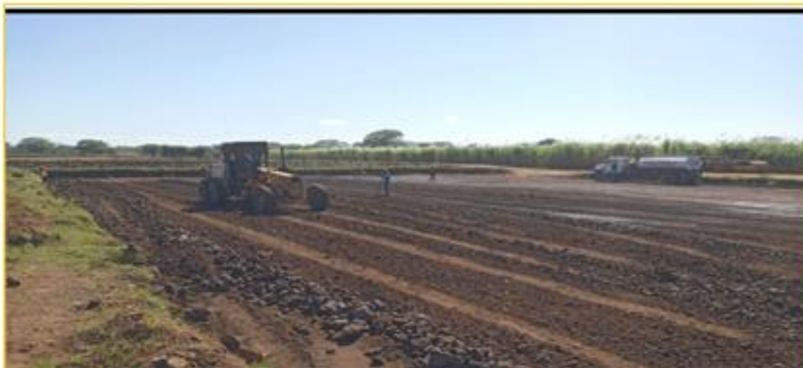
SE TRABAJA EN REPARACION DE PERFILES EN BERMAS DE LAGUNAS DE MADURACION. PROYECTO: "MEJORAMIENTO Y AMPLIACIÓN DEL SISTEMA DE ALCANTARILLADO SANITARIO Y DE TRATAMIENTO DE AGUAS RESIDUALES DE LA CIUDAD DE CHICHIGALPA."
